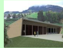
Beschickung direkt in Heizzentrale
